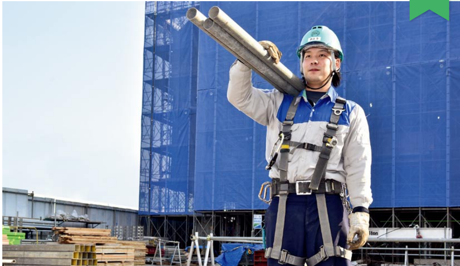
足場を組むための鉄パイプは1m約3kg、10本まとめて担ぐことも
