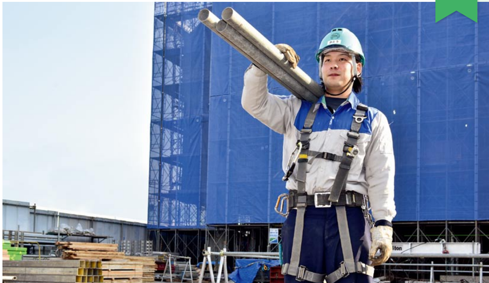
足場を組むための鉄パイプは1m約3kg、10本まとめて担ぐことも
