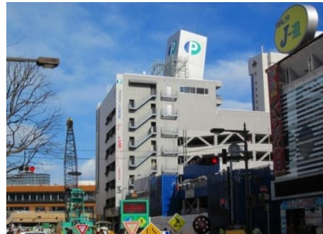
市内駐車場ビル被害 塔屋傾き
