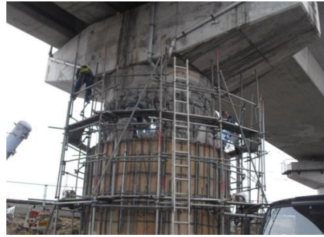
新幹線橋脚復旧工事
