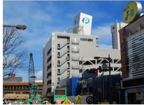
市内駐車場ビル被害 塔屋傾き
