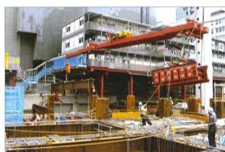
鉄骨大梁、重心可変吊り込み
