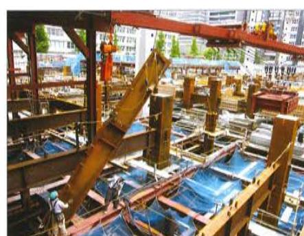
狭隘部へ斜め吊り鉄骨大梁を呼び込み
